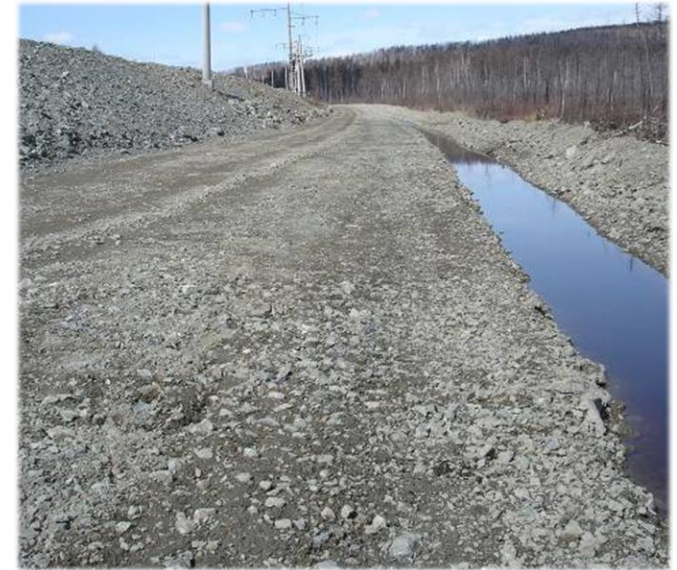
Водоотжимные бермы и водоотводные каналы
