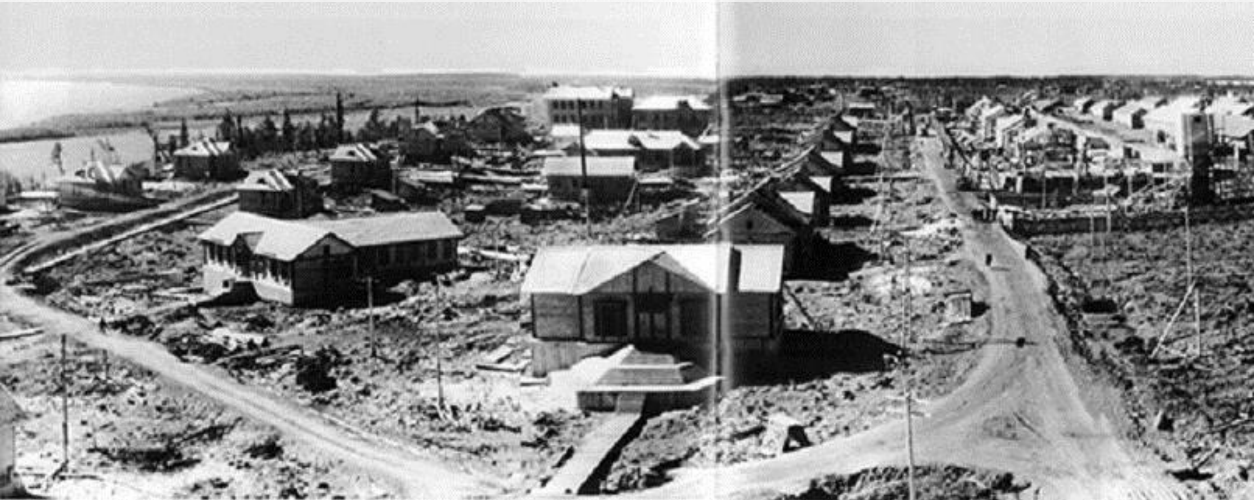
Поселок Ермаково Штаб стройки № 503
