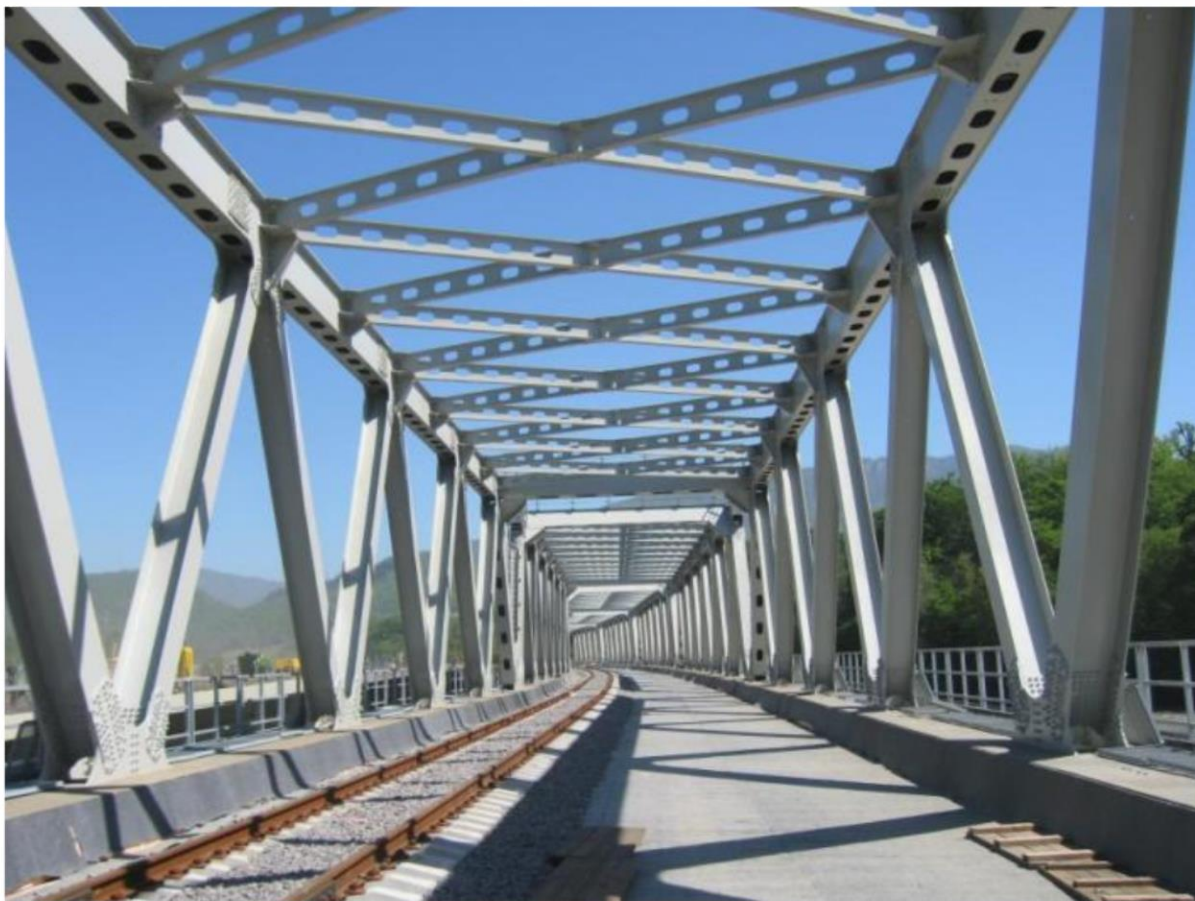
Пролётные строения с ездой на балласте
